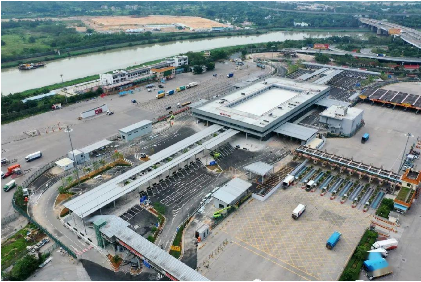
现已加建皇岗口岸临时旅检区
