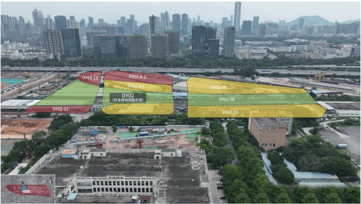
图8 项目场地现况图(场地北侧视角)
