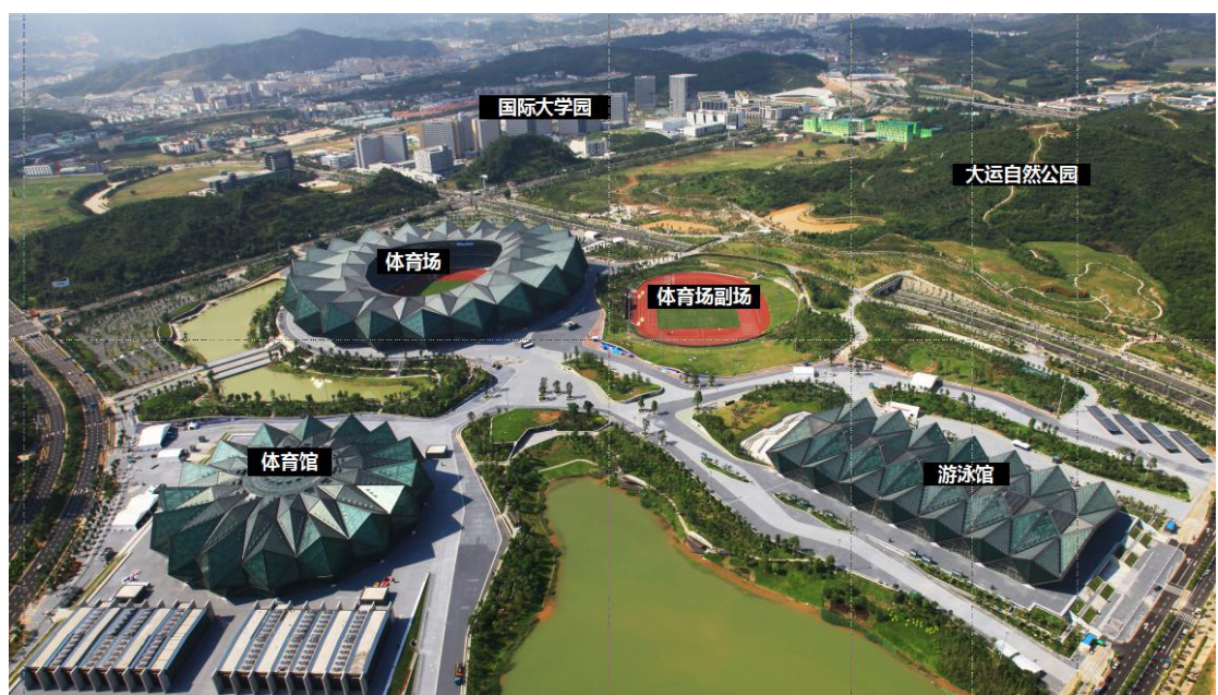
图 1-5 大运中心项目现状航拍图
