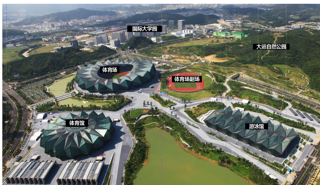
图2 大运中心项目现状航拍图
